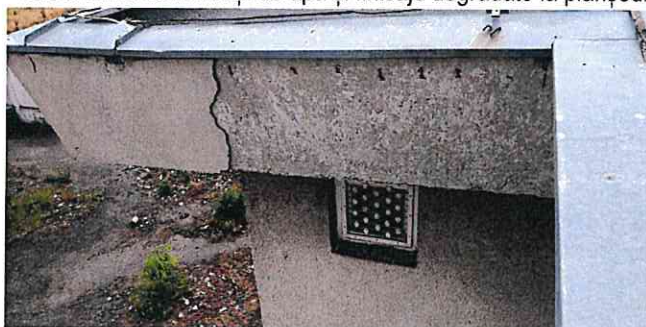
Fig. 3-Degradări la nivelul aticului
